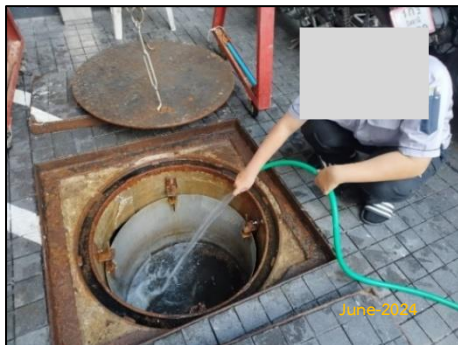
รูปที่ 2-21 การตรวจสอบและการทำความสะอาดบ่อบำบัดน้ำ
