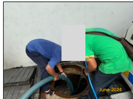
รูปที่ 2-13 การสูบน้ำส่วนเกินจากระบบบำบัดน้ำเสีย
