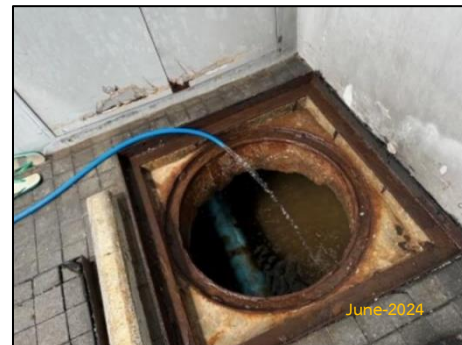
รูปที่ 2-21 การตรวจสอบและการทำความสะอาดบ่อบำบัดน้ำ
