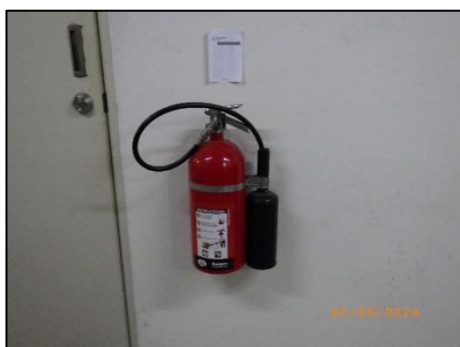
รูปที่ 2-30 เครื่องดับเพลิงแบบมือถือ
