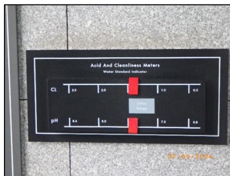
รูปที่ 2-65 การตรวจสอบความเป็นกรดและด่าง และคลอรีนอิสระของน้ำสระว่ายน้ำ
